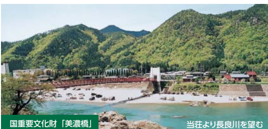
国重要文化財「美濃橋」
